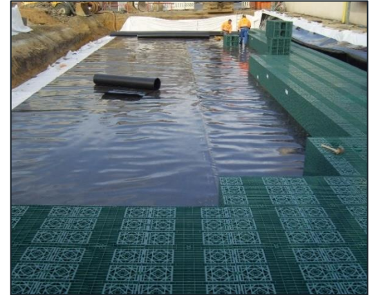
Durch Rückhaltung über Rigolen
